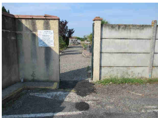
Entrée 3 – cheminement et parking PMR
