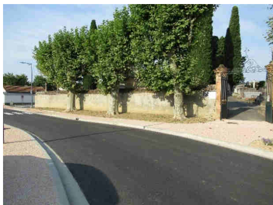
Entrée 1 – cheminement et parkings PMR
