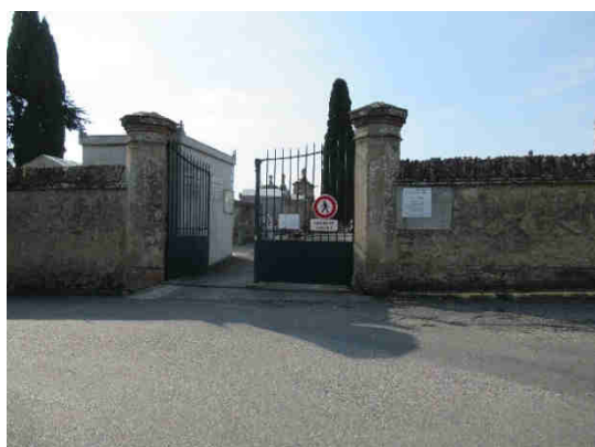
Entrée 2 – cheminement et parking PMR
