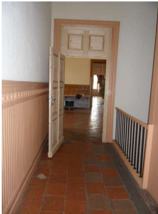
MAIRIE ETAGE TRAITEMENT DES PORTES
