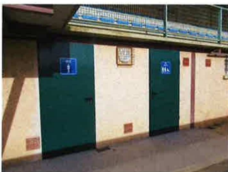
Mise aux normes Toilettes Publiques
