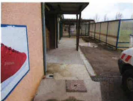
Réalisation cheminement horizontal avec grille PMR
