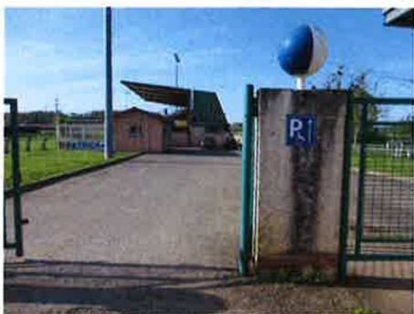
Réalisation stationnement PMR
