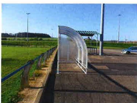
Mise en place Abri PMR
